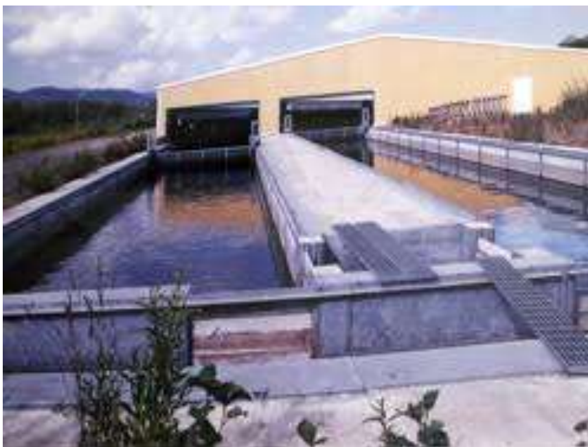
Рисунок 12 – Железобетонные прямоугольные бассейны
