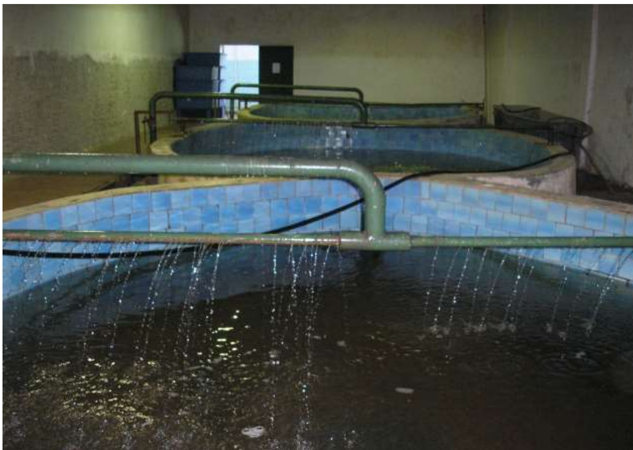
Рисунок 8 - Бассейны конструкции Б.Н. Казанского с рециркуляционной системой водоснабжения и регулируемой температурой воды
